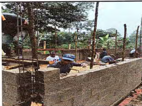
Foto1: Se reparan las paredes del salón de clases.
