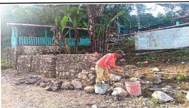
Foto 5: Se procede a colocar muro de piedra para fortalecer el muro de la cocina.
