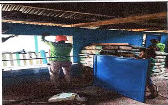
Foto 1: Se procede a la instalación de las ventanas de metal de la cocina
