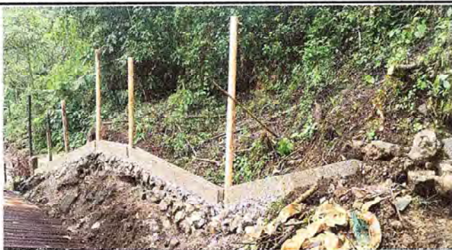
Foto 3: Para una mejora en el cerco perimetral se procede a colocar dos tiras de block
