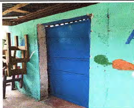
Foto 4: Se procede a instalar las puertas de metal. Para tener una mayor seguridad.
