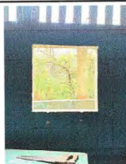
Foto 2: Se retiran las ventanas de madera para instalar las de metal.
