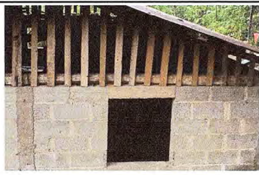
Foto 6: Se procede a retirar las ventanas de madera, para posterior colocar las de metal.
