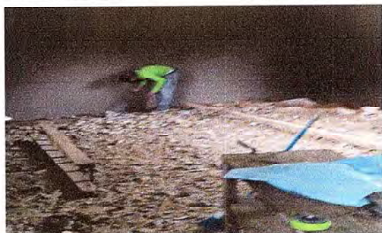
Foto 3: Se procede a retirar el piso dañado para colocar el piso nuevo.
