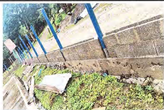
Foto 4: Mejorando el Cerco perimetral en todo el contorno de la escuela
