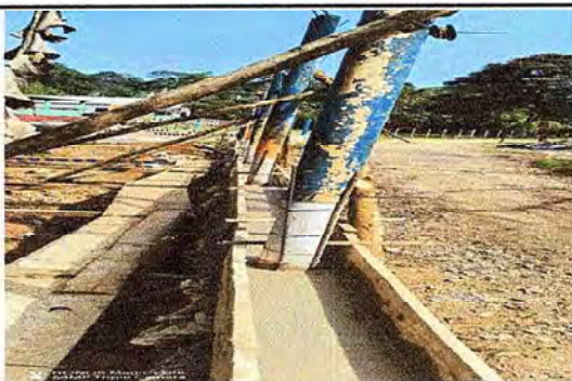
Foto 5: Colocando base para la malla del cerco perimetral
