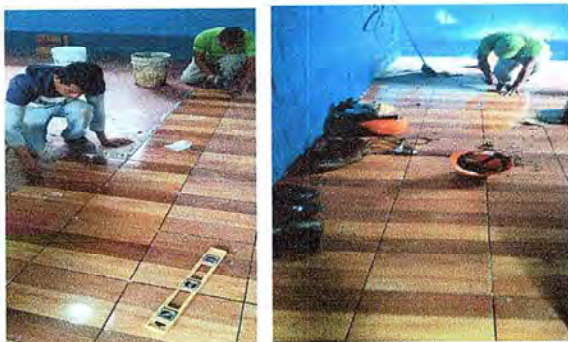
Foto 3: Se instala piso nuevo al salón de clases.
