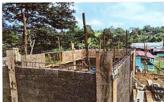
Foto 5: Se retira el techo del salón para instalar la estructura de metal nueva.
